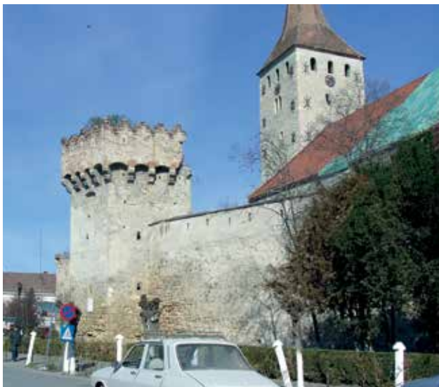
Wehrturm vor der Sanierung
